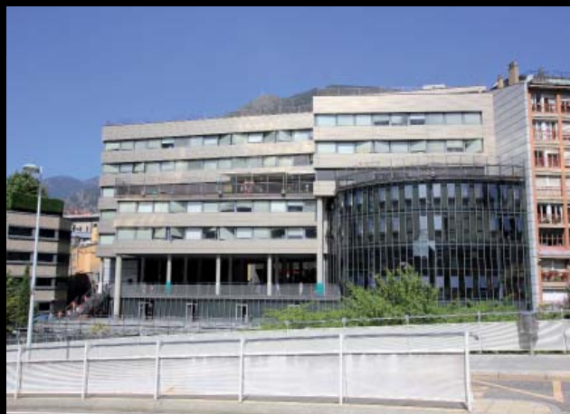
Escola d'Ensenyament Primari, Escaldes-Engordany
