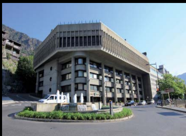
Edifici administratiu de Govern, Andorra la Vella
