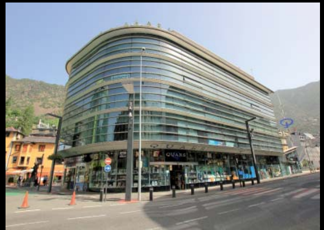
Edifici Quars, Andorra la Vella
