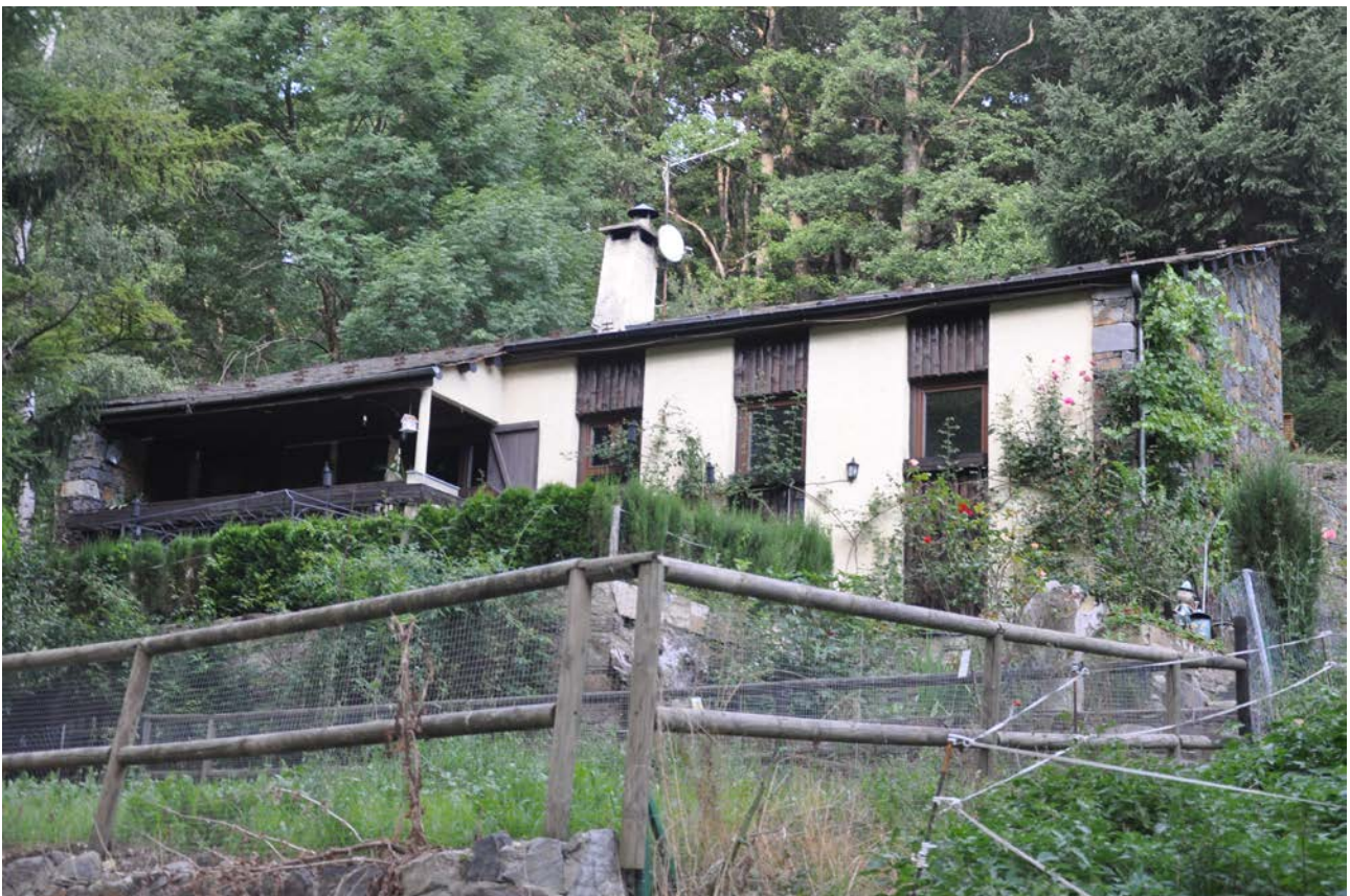
Foto de l'edifici de la parcel·la número 45 de les Costes.
