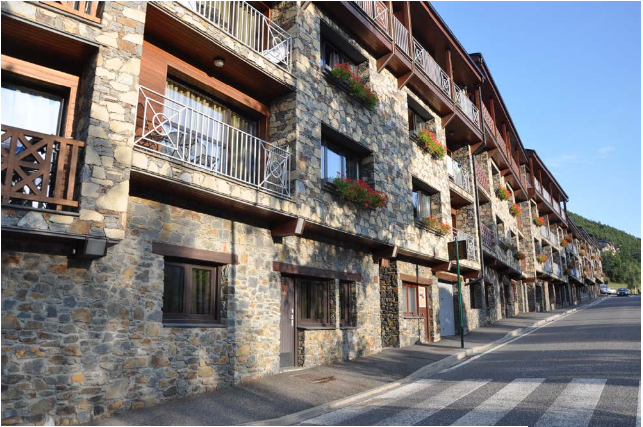
L'edifici d'apartaments remodelat.
