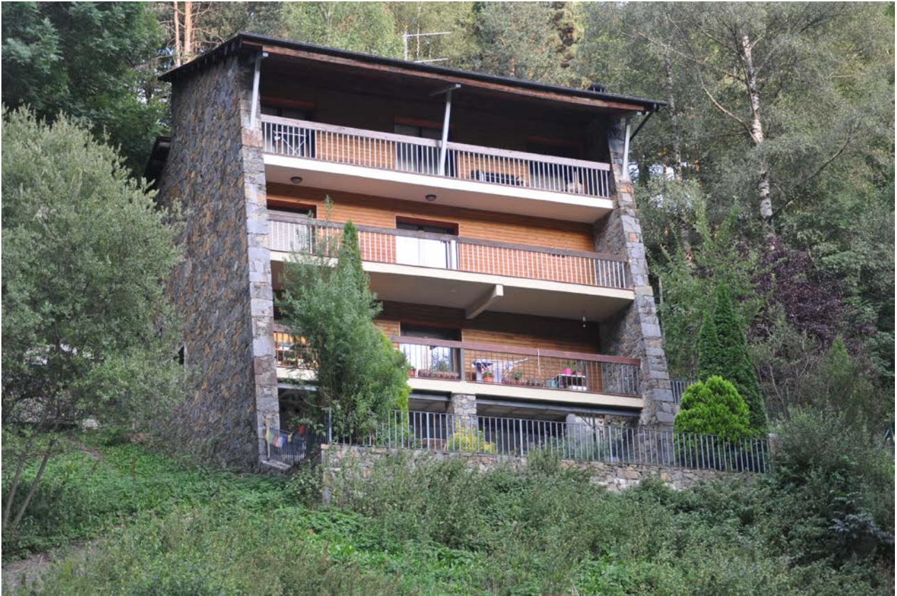
Foto de l'edifici de la parcel·la número 41 de les Costes.
