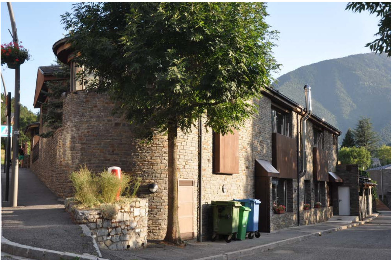
Edifici que va substituir a l'snack-bar d'Escorsa.
