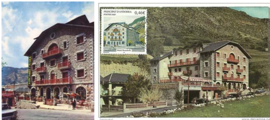
Postals de l'hotel amb la transformació del llosat ja executada (todocoleccion.net i delcampo.net). Podem veure també com la terrassa sobre el garatge es cobreix, inicialment amb tendalls i posteriorment amb una estructura fixa.
