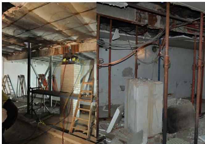
Fotografia del pilar seccionat en planta soterrani després de l'apuntalament de l'estructura i fotografia de la seva restitució i aixecament del forjat mitjançant gats hidràulics (E. Dilmé).
